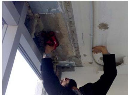
Détection de ferrailage de la dalle pour supporter la façade
