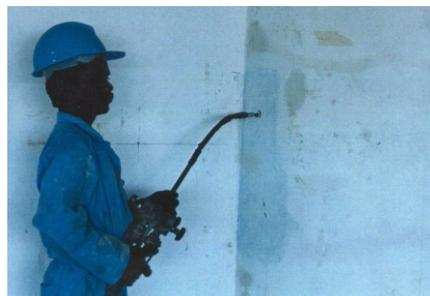
Consolidation des voiles par béton injecté
