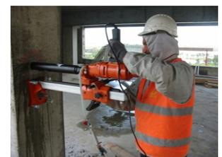
Fixation de l'appareil et opération de carottage
